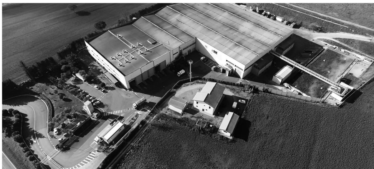
Figura 2 Ecologia Viterbo S.p.A. Impianto TMB, S.P. Teverina km 7,63 - 01100 Viterbo
